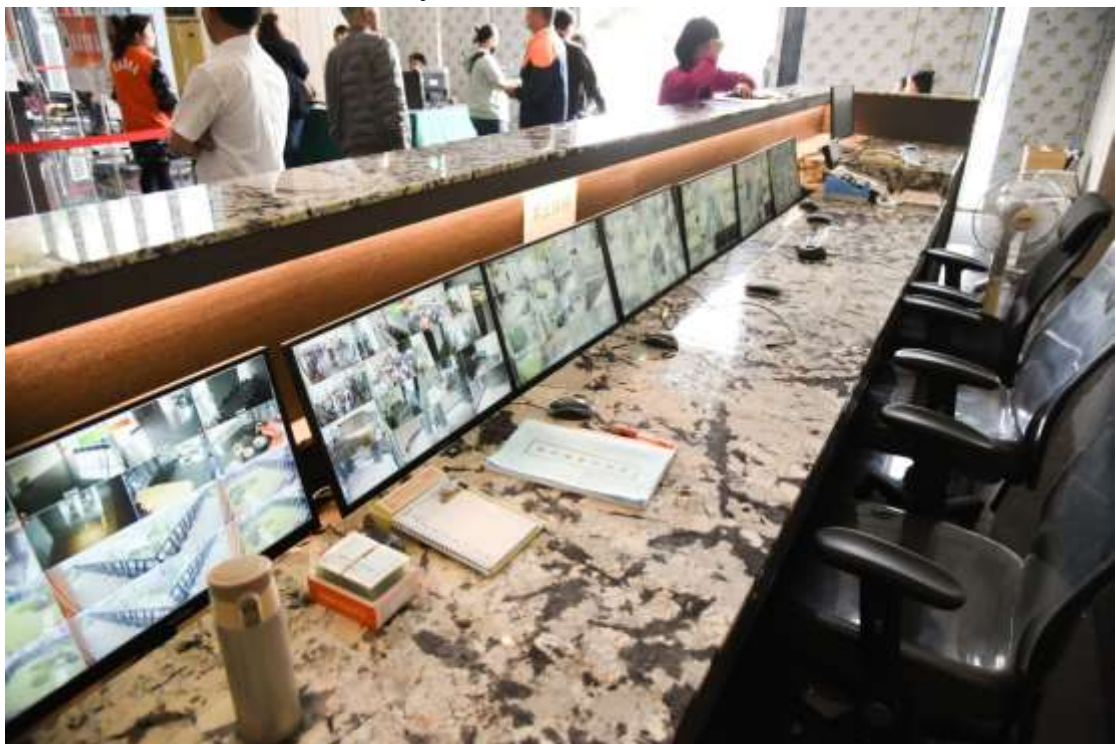
大樓監視器 Security Surveillance Cameras
